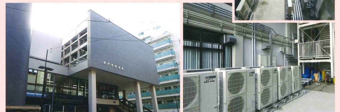
外壁改修(小畑建設様施工)の中、邪魔をしながら外壁の冷媒配管工事を施工。営業中の談話室に配管材を放置しながら天井を解体、機器を吊込み。40数年前に当社で施工したターボ冷凍機を解体、ユニット式の水冷チラーを据付、ボイラーの更新。数ある申請書類を作成しながら長かった工事もやっと竣工、松戸市民に愛される憩いの場所として生まれ変わりました。
